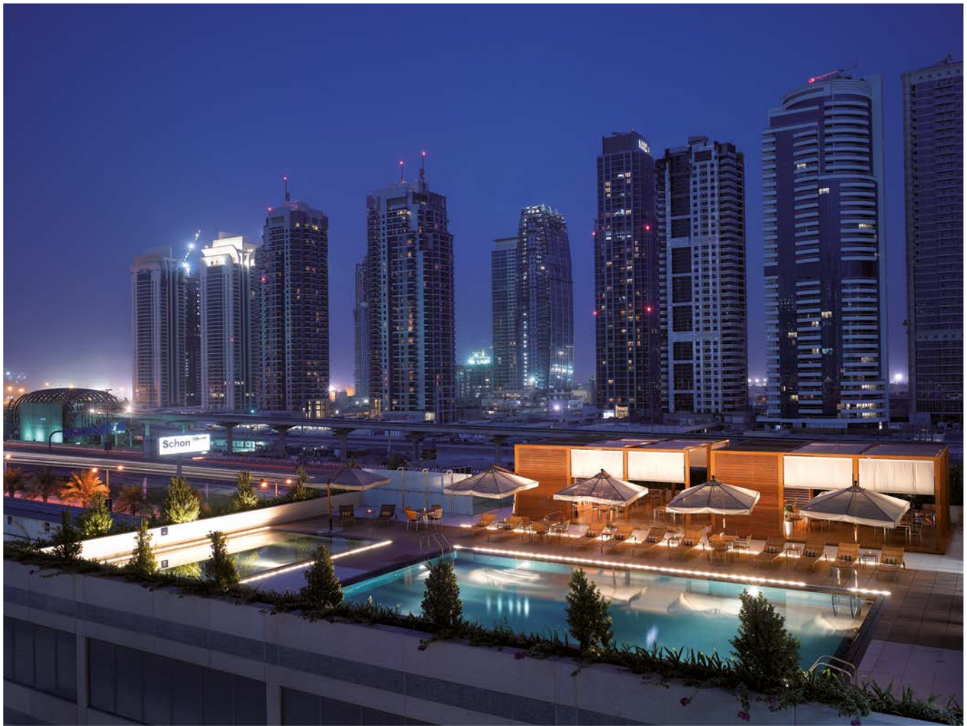
"VQ Ventiquattro Radosson SAS Residence" - Dubai Marina - UAE
