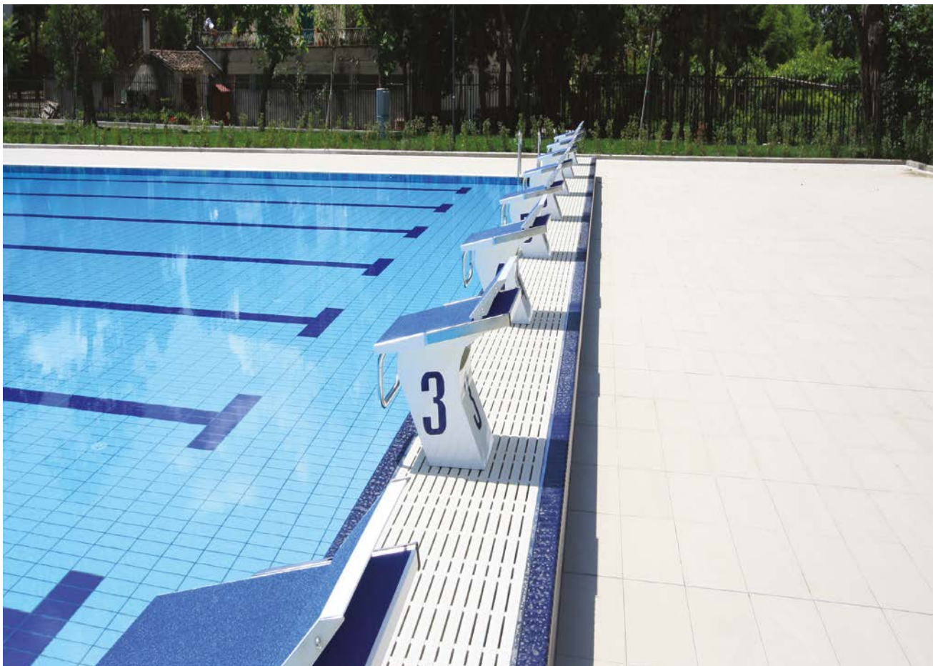
"Piscine Dello Stadio" - Terni (TR) Italy
